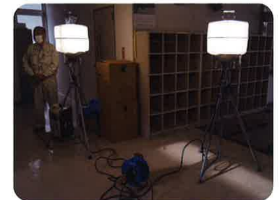
松ヶ崎連絡所では投光器に電気を供給
